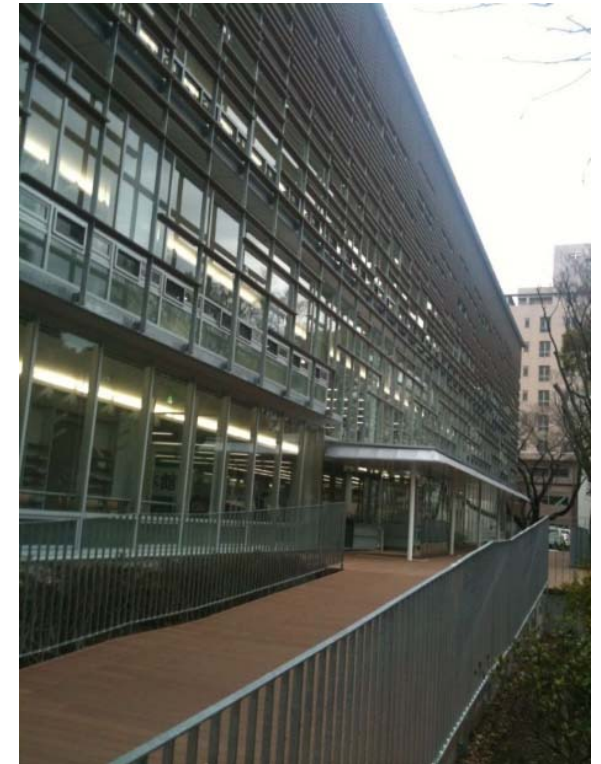
本館（西千葉）入口
